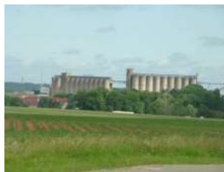
Silos – Commune de Courville-sur-Eure
